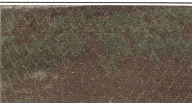
Reparación de tubo hg y malla galvanizada
